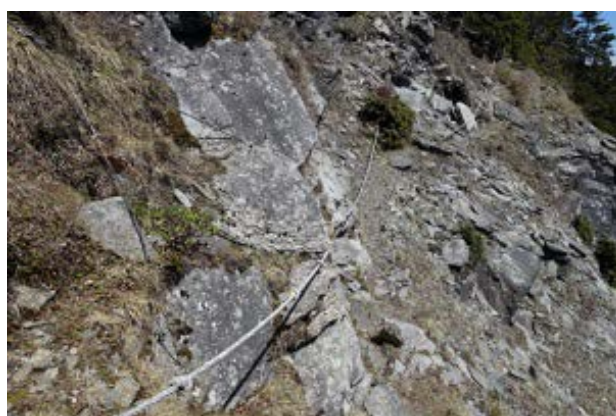
圖 2、崩塌坡面，請注意通過
