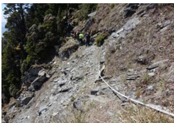
圖 1、崩塌坡面，請注意通過
