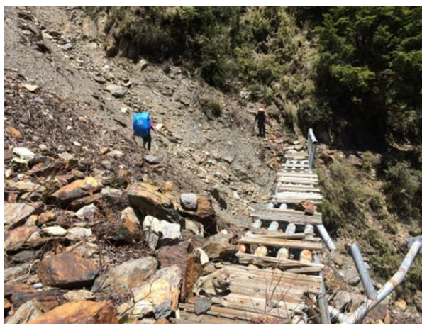
圖 4、棧橋毀損，請小心通過崩壁
