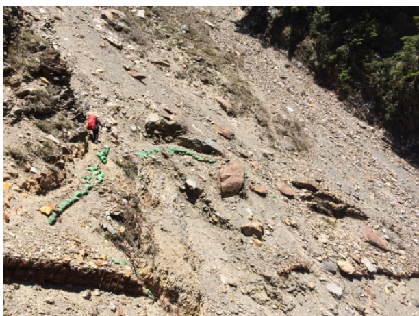
圖 5、大面積崩塌坡面，請小心通行
