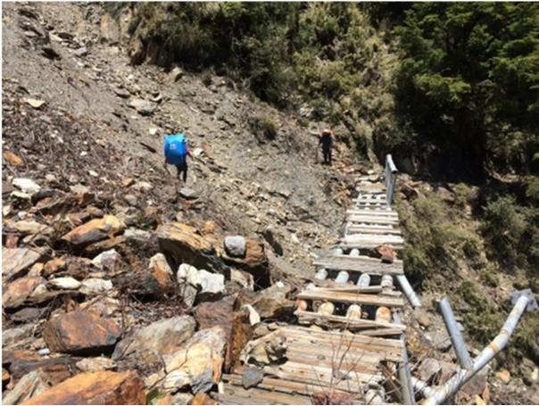
圖 3、棧橋毀損，請小心通過崩壁。
