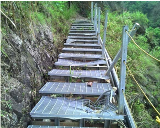
圖 1、落石區常發生崩塌落石，請注意通行
