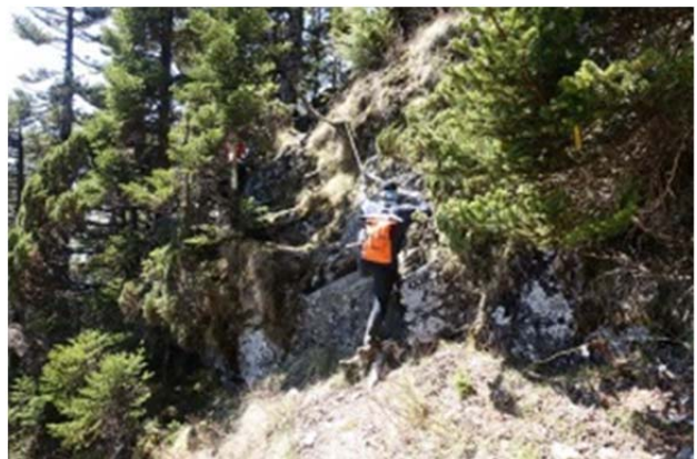
圖 4、崩壁，請注意通行
