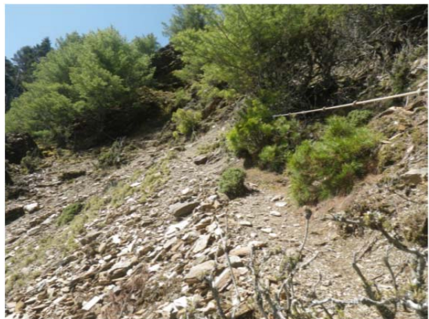
圖 2、崩塌坡面，請注意通過
