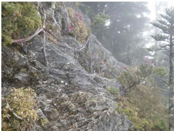
圖 3、崩壁，請注意通行
