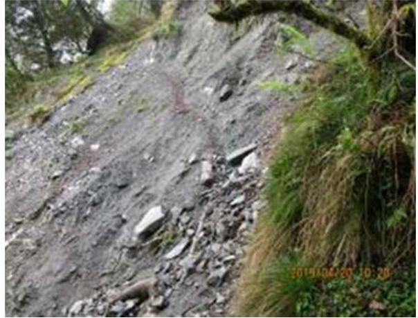
圖 4、崩塌，路基狹窄，請注意通行
