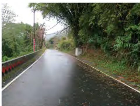
部落聯外道路鋪面維護
