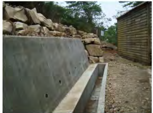
混凝土擋土牆及排水溝
