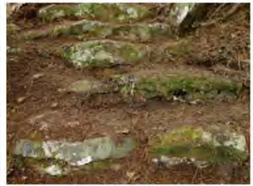
清朝八通關古道遺址阿波蘭水池（qaqatu） 西方約500公尺處的石階群
