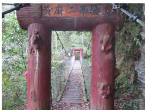
黃麻二號吊橋維修
