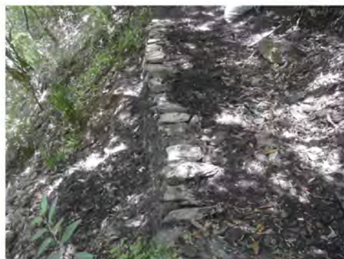
漿砌石路基修繕
