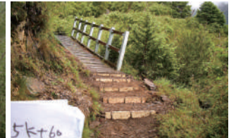
橫板路基修繕
