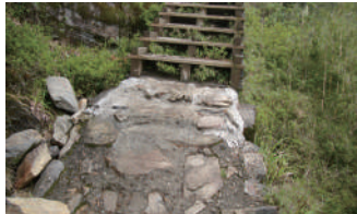
階梯起點塊石修繕
