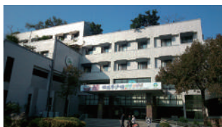
訓練中心外牆修繕
