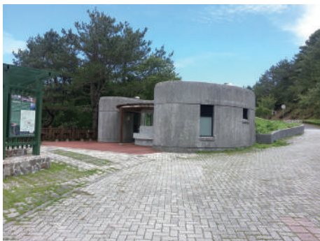
人性化公廁設施整修
