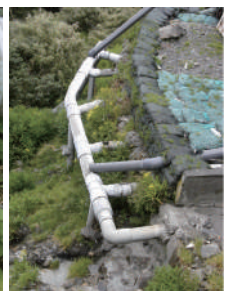
排雲山莊化糞管破損移位修繕完成
