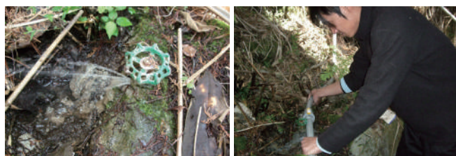
2月28日楠溪水管漏水整修
