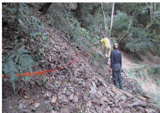
八通關步道約6.5K處 以傘帶補強崩塌處路徑
