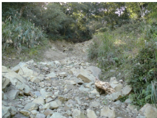
大型向源侵蝕，有擴大為土石流上游發生段的跡象。
