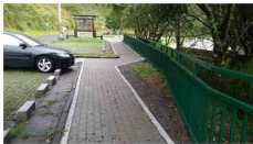
人行步道透水磚鋪設
