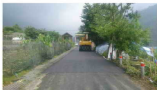
部落聯外道路 AC 鋪面施設
