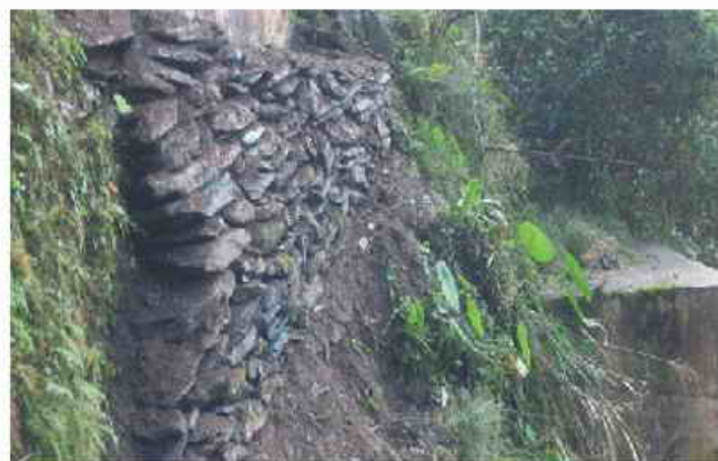
橋台基礎砌石擋土設施維護
