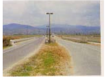
照片 3 墾丁國家公園四--一號道路入口處之射寮橋
