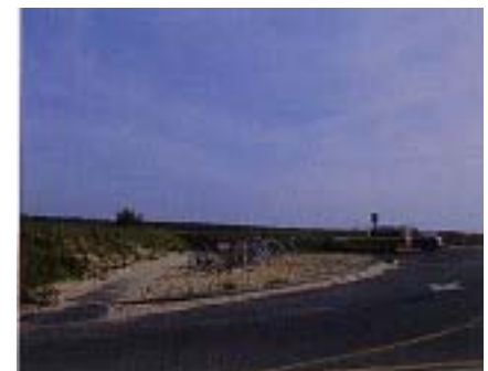
照片 64 美國 Cape Cod 國家海濱區道路停車場及自行車道
