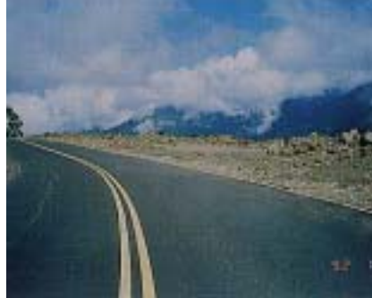
照片 87 國家公園景觀道路沿線崩塌裸露地應立即進行植栽復舊美化
