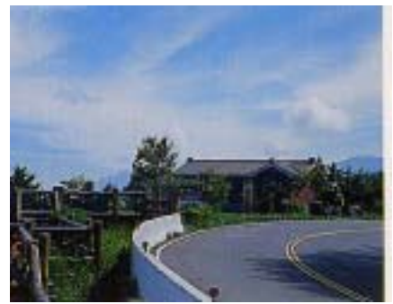
照片 51 國家公園景觀道路設置服務站、人車分道、眺望台、停車場、公廁等等遊憩設施
