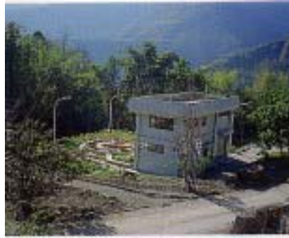
照片 26 玉山國家公園南橫公路梅山污水處理廠
