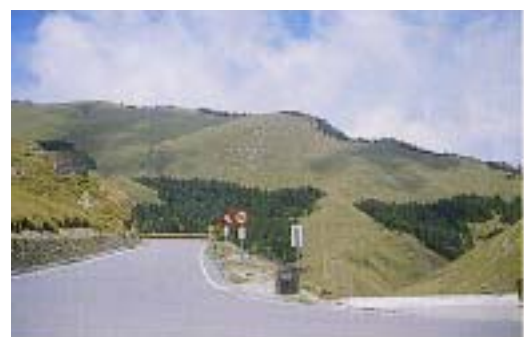
照片 56 國家公園景觀道路設有各種安全護欄及警告牌誌預防意外發生
