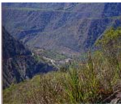
照片 19 玉山國家公園南橫公路蜿蜒於高山溪谷間
