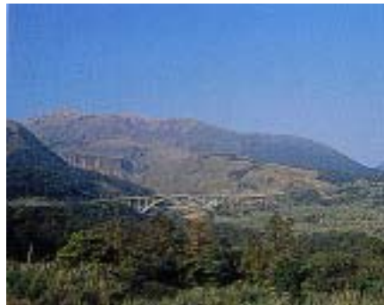
照片 41 陽明山國家公園陽金公路造型特殊馬槽橋
