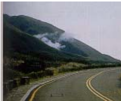
照片 52 國家公園景觀道路各項設施之造型、材質、色彩等皆與自然環境相調合
