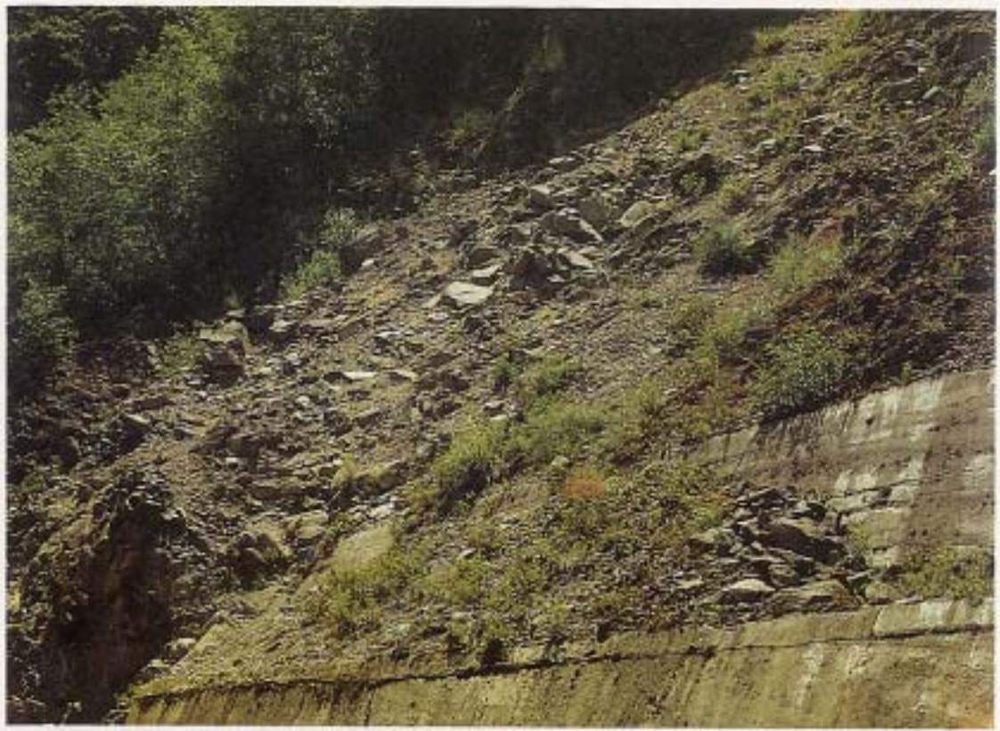
▲照片 6-39，133.15K。護牆產生有效之阻擋作用。
