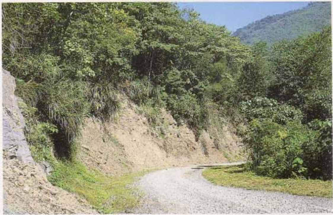
▼照片 6-4 No.9 112.2K，土石崩落及圓弧型滑動。表土風化層因受到公路開挖切過以及大雨對表土的沖刷而產生土石崩落及圓弧型滑動的情形。梅山層硬頁岩。
