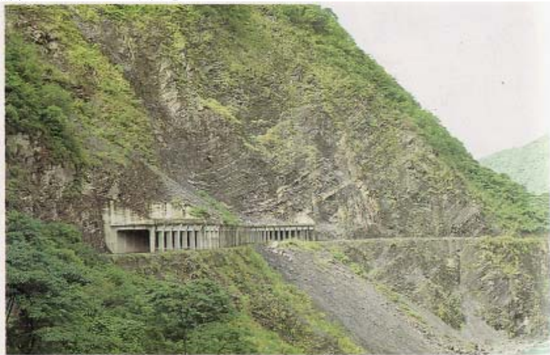
▼照片 6—44，105.5K。明隧道。
