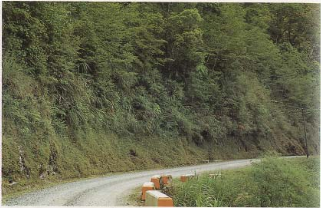
▲照片 6—43，132.5K。公路沿線植生良好之情形。
