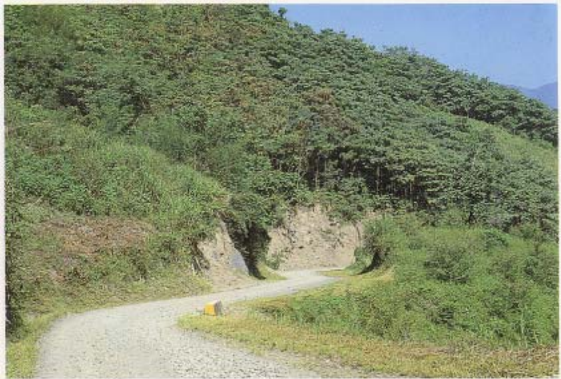
▲照片 6-3 No.9 112.2K 圓弧型滑動。及土石崩落之遠觀。
