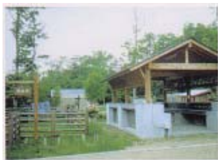
▲阿寒國立公園和琴半島園地野營炊事洗滌及污水處理設施
