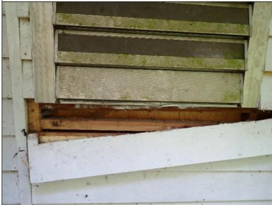
山屋後窗戶合板被熊扒落
