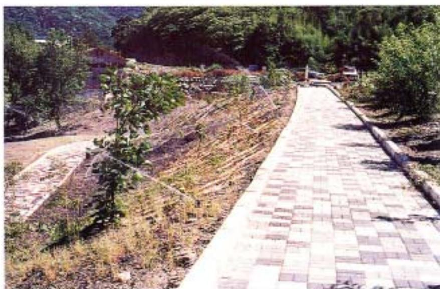
圖 3 - 3 A 區步道區採用高透水性的連鎖磚和碎石鋪面，以減少地表逕流
