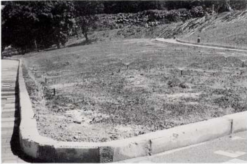
圖 4 - 3 園內灌溉系統自動噴水灌溉情形
