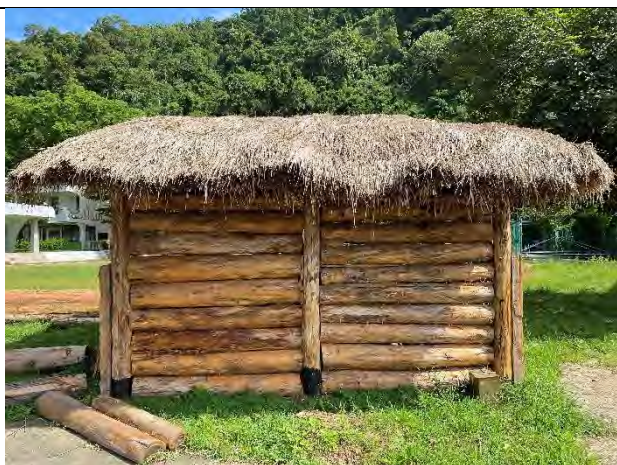
卓樂國小木構家屋牆面材質與結構
