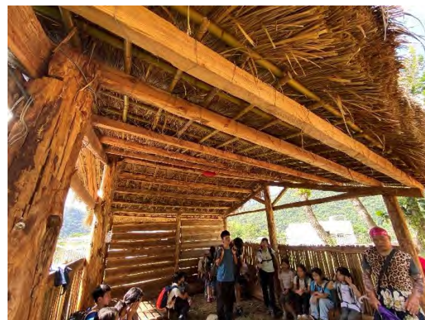
卓樂國小木構家屋屋頂結構
