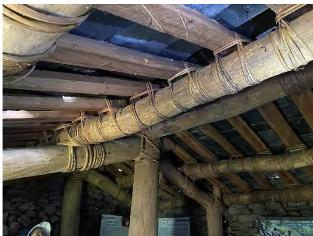
佳心家屋屋頂結構
