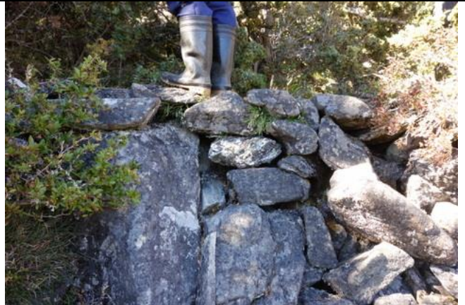
此處為靠近大水窟池的路段，使用現場取得的塊石建造浮築橋
