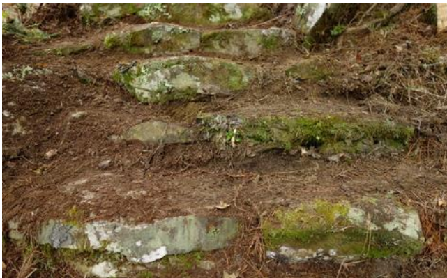
此為東段阿波蘭水池（qaqatu）西方約 500 公尺處的石階群，採用各類大小不一的塊石堆砌而成，有以大塊石層層堆砌而上（左圖），或是將小塊石以水平堆疊的方式砌成（右圖）
