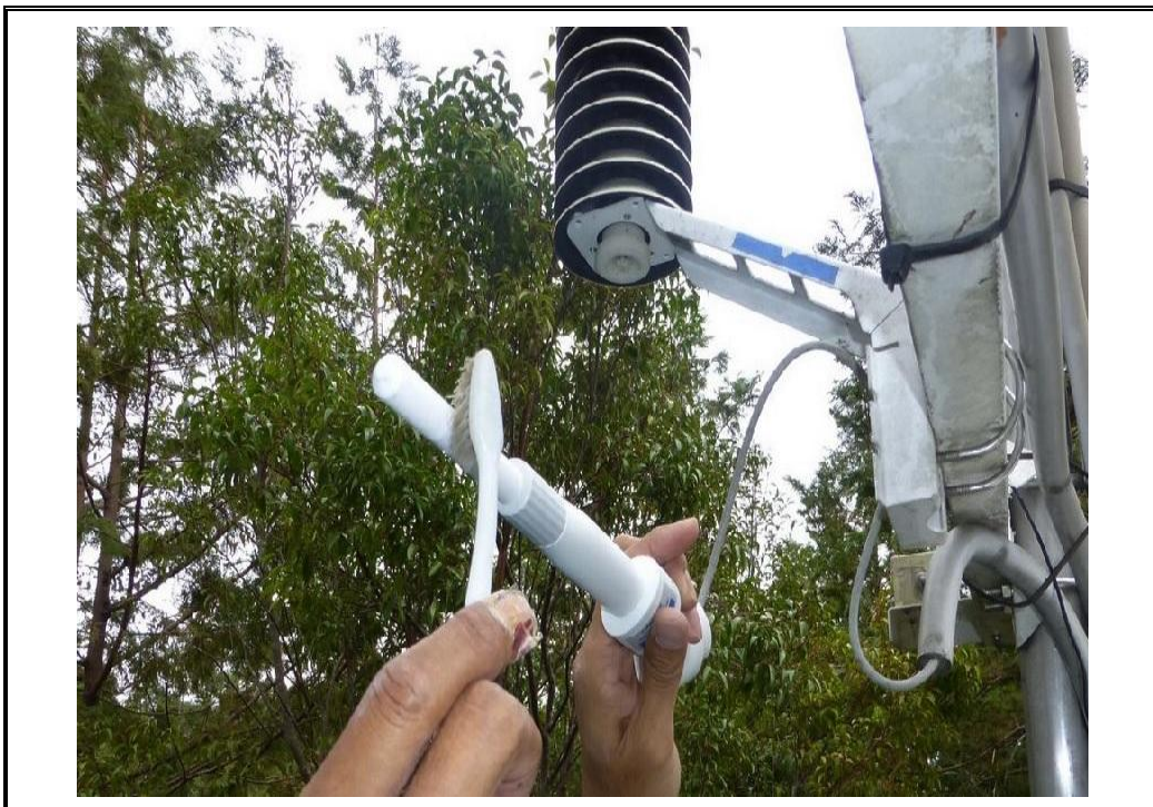
圖 22：天池站太陽能電壓量測
