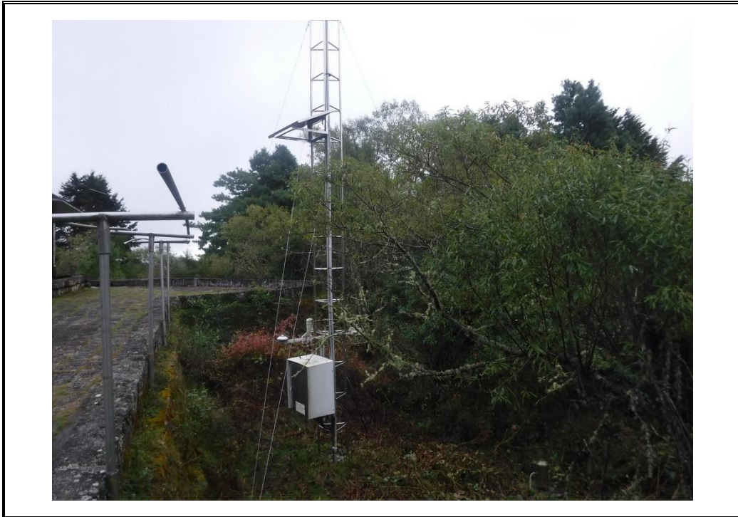
圖 1：塔塔加站保養前
