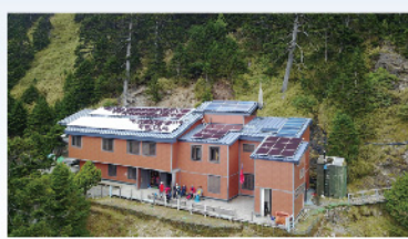
▲2013年完成排雲山莊鋼骨結構改建
