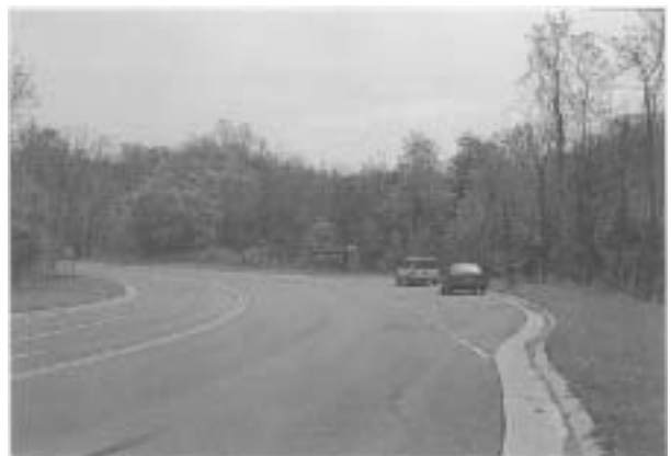
▲斯凱藍景觀公路遊憩設施完善，便於遊客停車照像或觀景的路邊停車點。
