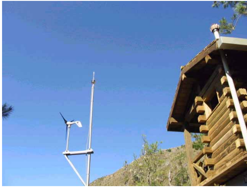
圖 (4-6) 風力發電機及避雷器
