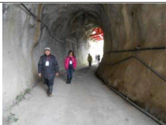
圖 51 穿過沙里仙隧道
