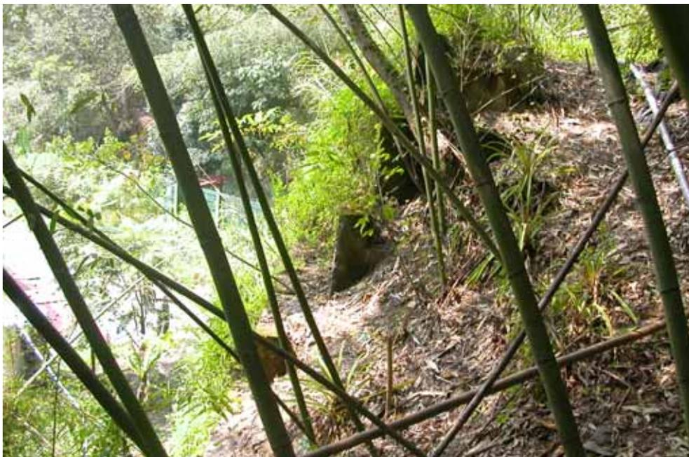
圖 3-4 擋土牆採階級式混凝土塊體疊砌而成，似有緩慢突出變形之現象，在擋土牆兩側有設置隔離護網，卻於其上方區段未有隔離護網措施
