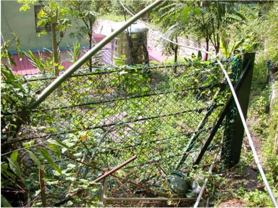
圖 3-3 為防範落石搗毀民宅設置隔離護網於擋土牆兩側之現況
