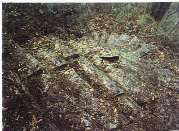
東埔斷崖對岸一段長達64階的石階路面，轉折處以精緻的手法砌成扇狀。
