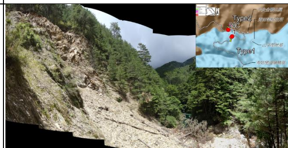
(D) 調查點 24C：舊崩塌擴大，土石擠壓荖濃溪河道，使原有潭面擴大。
