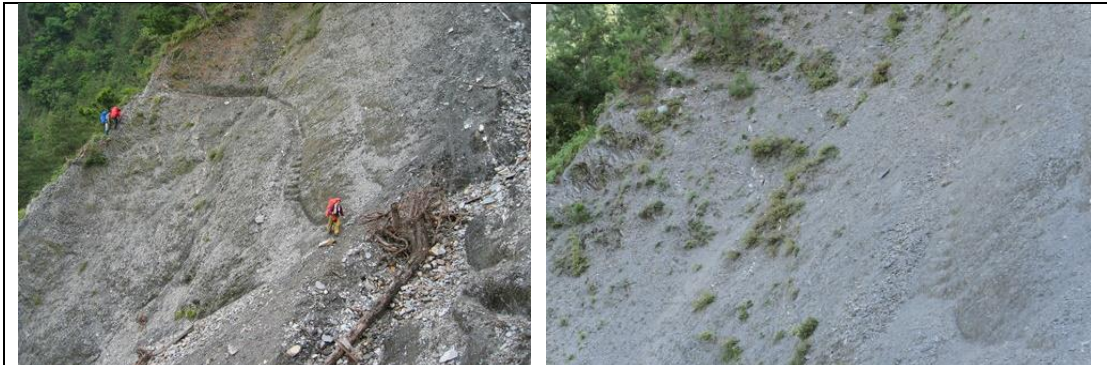
左為 2006 年土葛崩壁剛整修好時的照片，右為此次調查照片，可以發現當時開鑿的路基、腳點仍依稀可見，只要將上方土石清除便可通行
