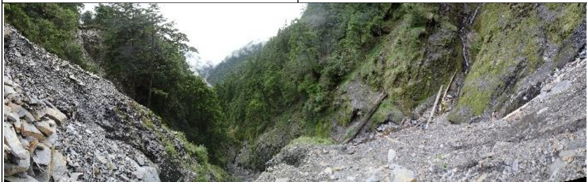
(D) Pre4：擬規劃吊橋之地形，照片左側為吊橋西端，右側為吊橋東端。
