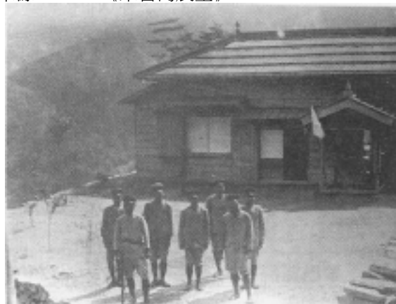
圖 19 魯崙駐在所的建築造形：平入、寄棟造、切破風、下見板
