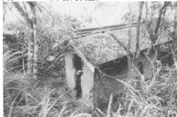
圖 20 鋼筋混凝土造的大分彈藥倉庫現況
