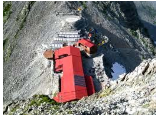
*以太陽能光電板及輕油發電
