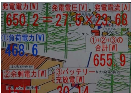
發電電力電壓電流量顯示儀板
