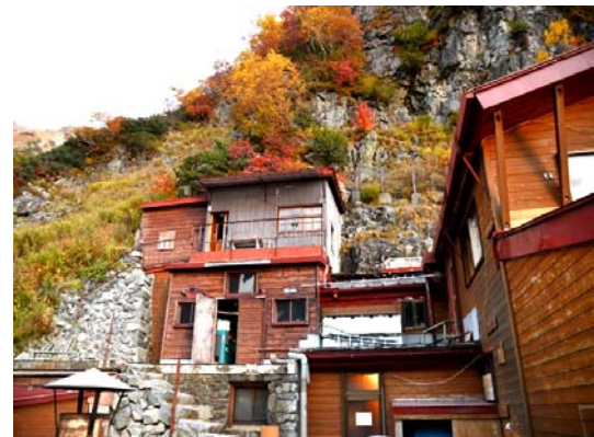
獨立的發電機房
