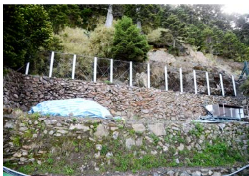
排雲山莊終站興建受電變電站
