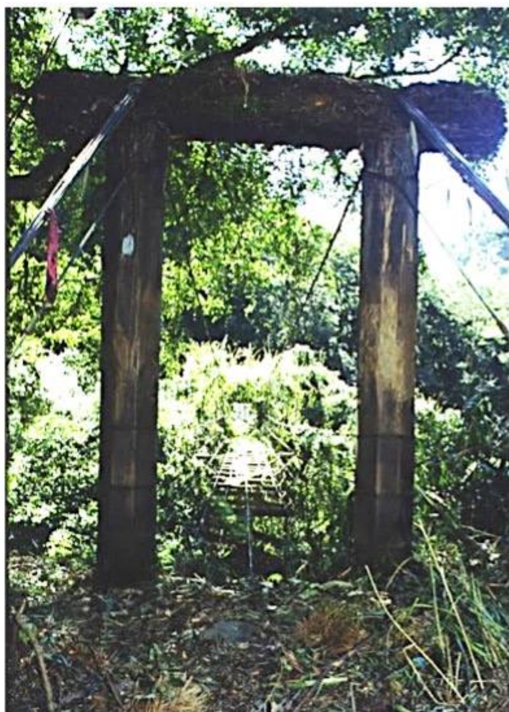
【照片 1-01】2001 年意西拉鐵線橋南側橋門柱。
