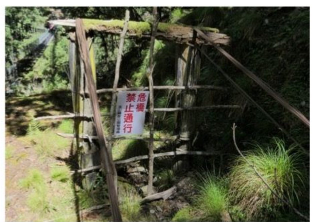
【照片 1-08】2017 年意西拉鐵線橋北側橋門柱。
