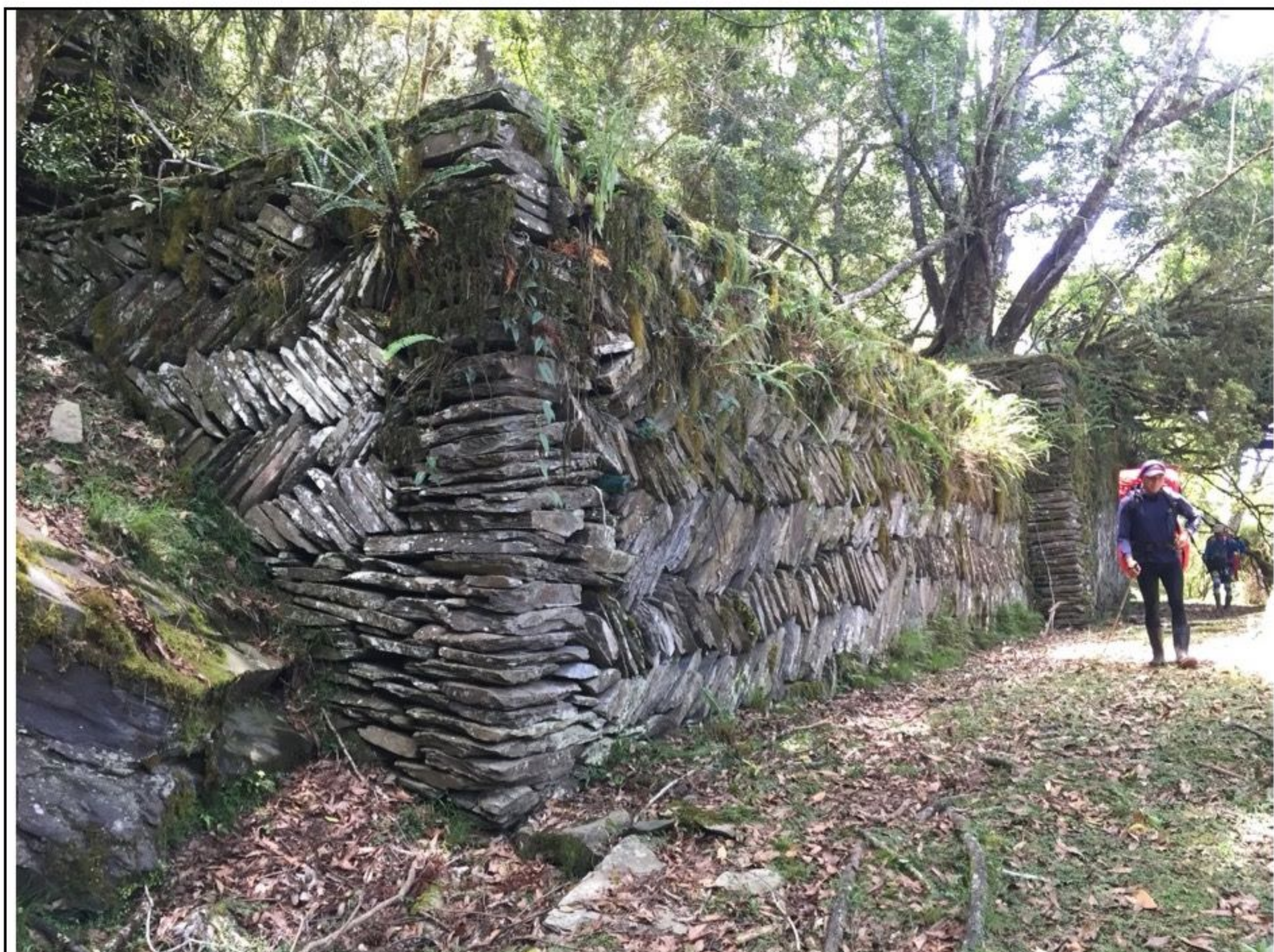
【照片 2-13】北側砌石駁坎。
