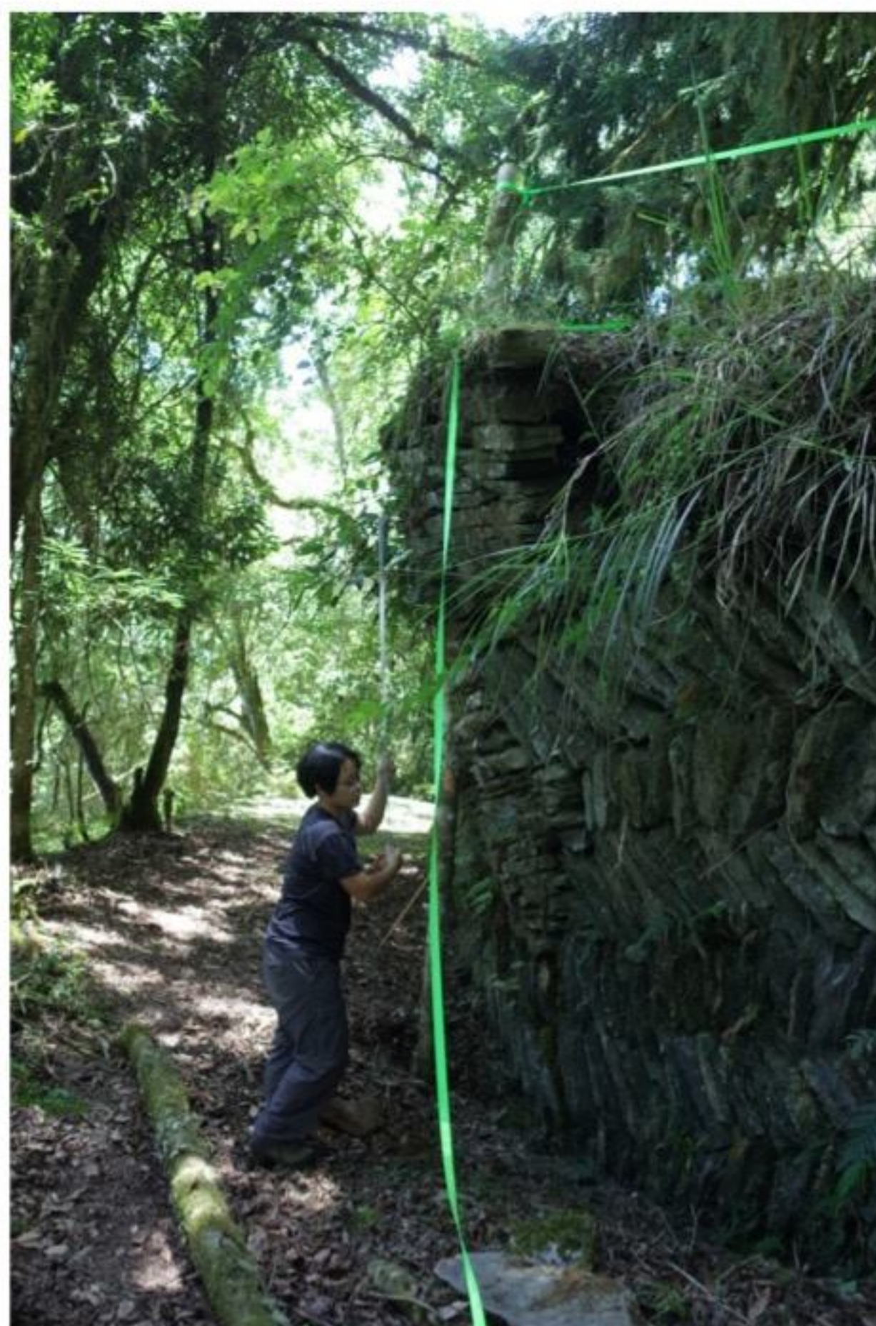
【照片 2-10】預防上方石板墜落加固。
