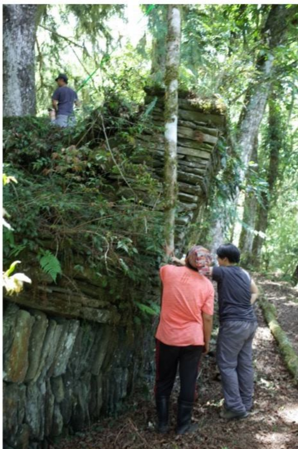
【照片 2-09】預防上方石板墜落加固。
