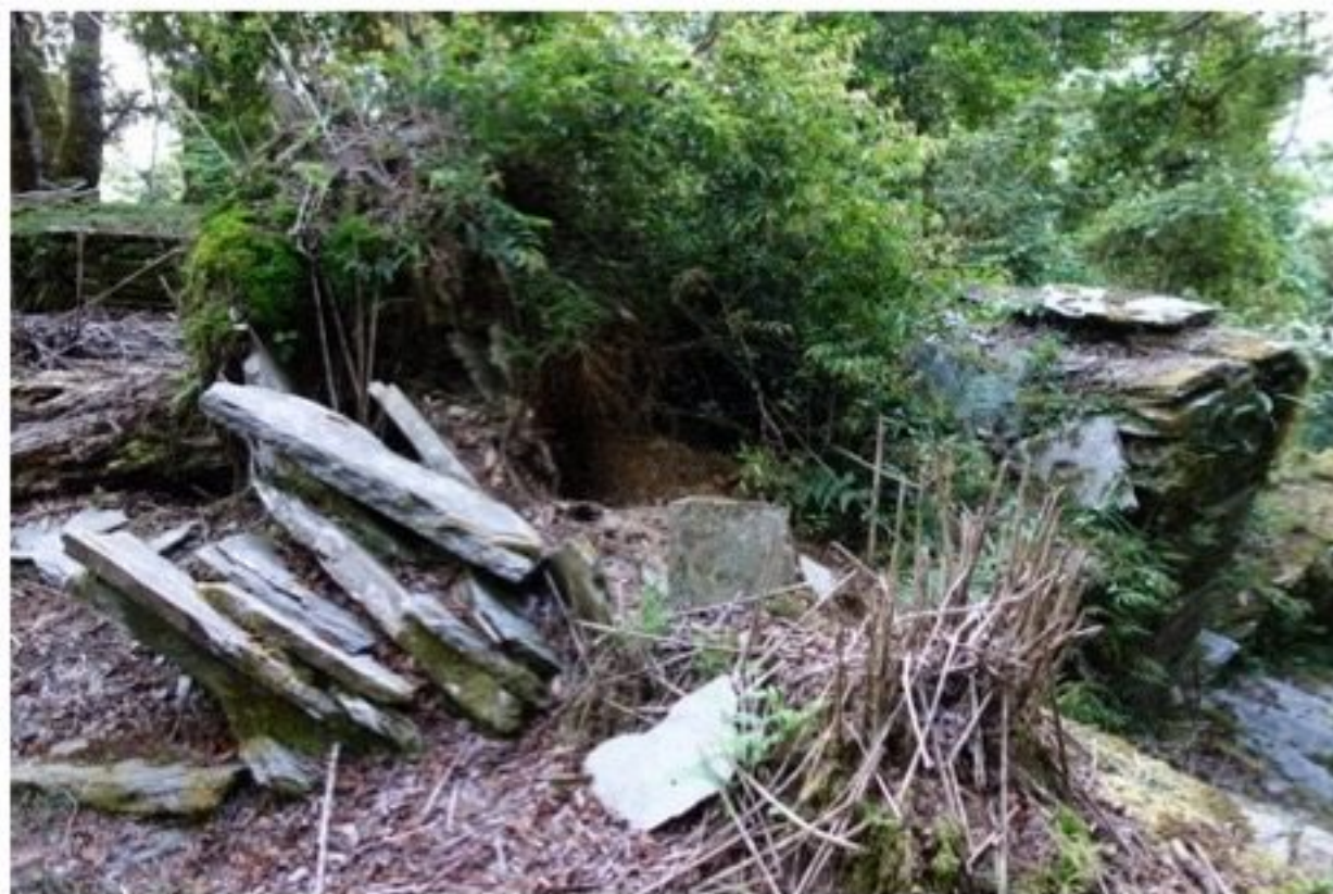
【照片 2-05】2011 年遭山豬破壞的砌石牆。
