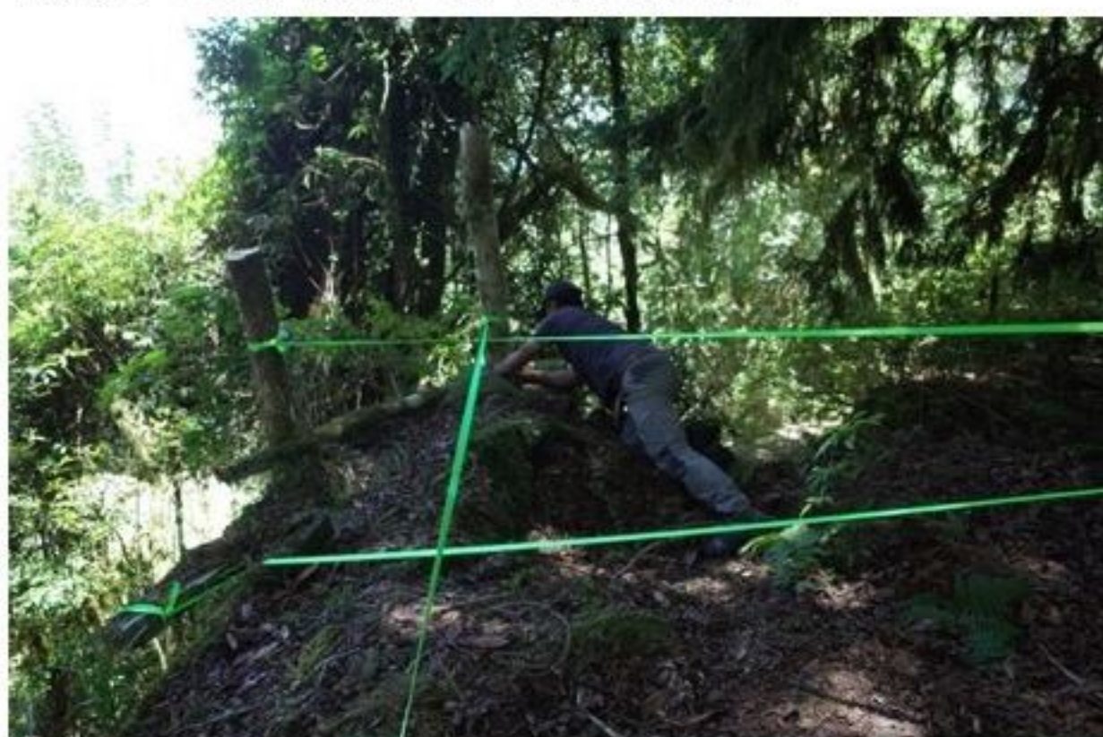
【照片 2-11】預防上方石板墜落加固。
