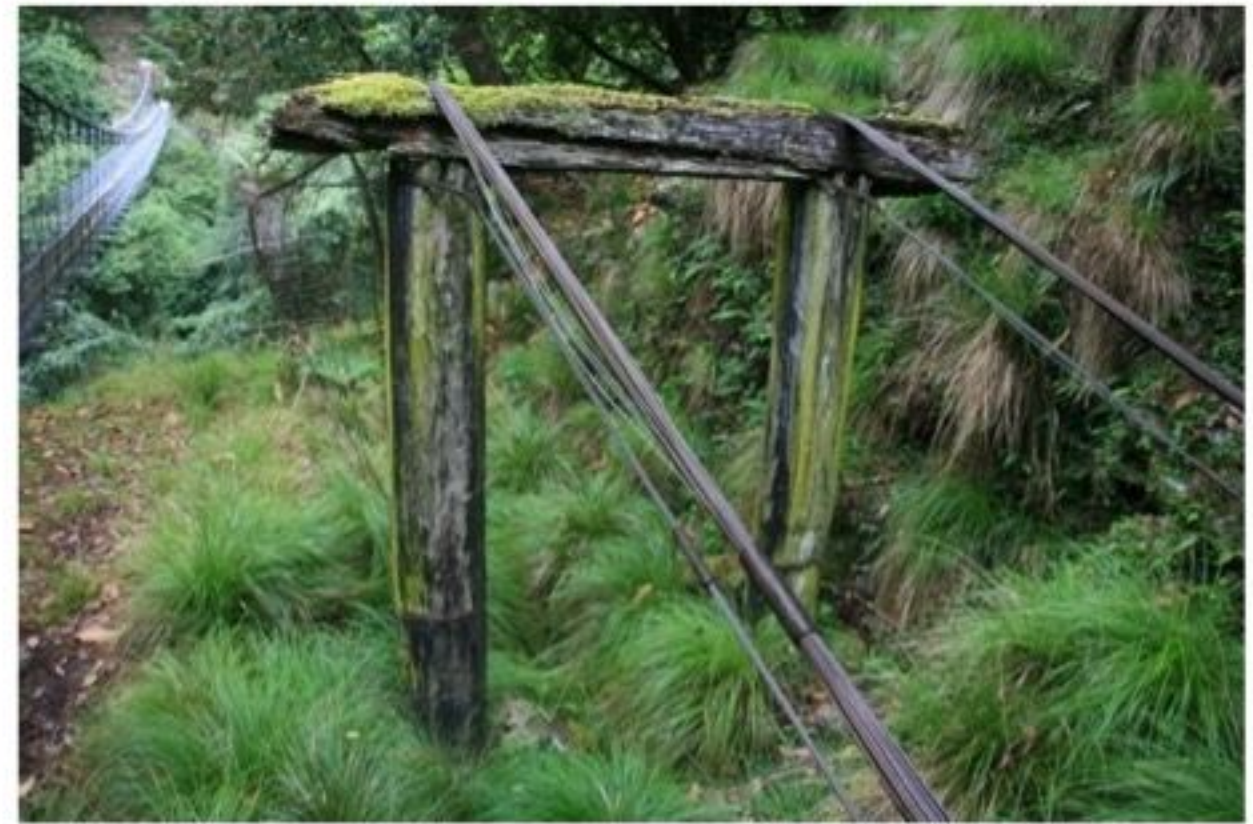
【照片 1-06】2011 年意西拉鐵線橋北側橋門柱。
