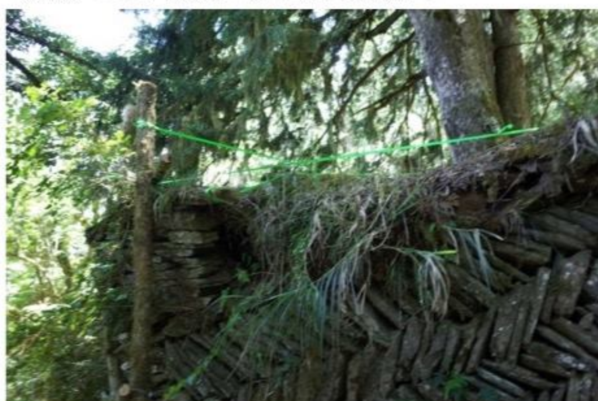
【照片 2-12】預防上方石板墜落加固。
