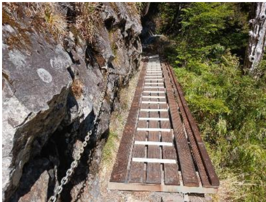
塔塔加-主峰5.43K 鋼構路基改善
