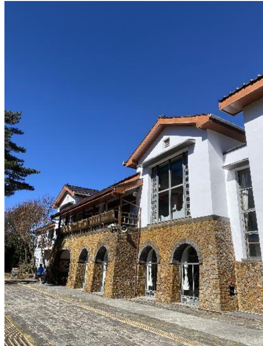
塔塔加遊客中心外牆粉刷
