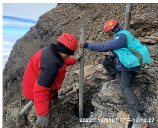
12 月 15 日地震後，山莊管理員方有水帶領何正道、柯群凱共 3 人前往主峰線步道震損處進行維修，於現場零下 2 度及強風之惡劣環境下進行維護及搶修，以提升登山安全。
