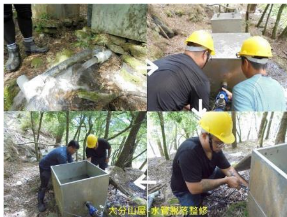
設施維護大分山屋水管
