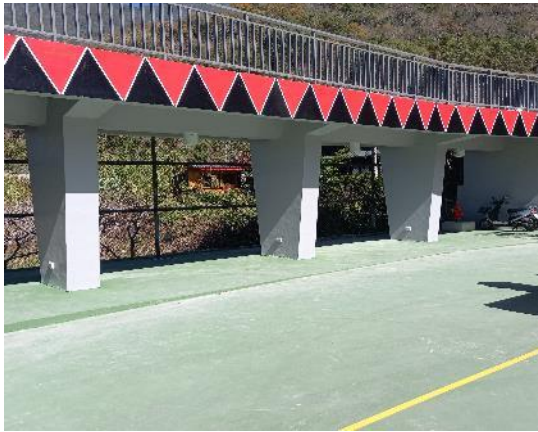
斜坡通道瞭望台
