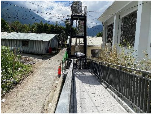
新設斜坡道串聯步道與東埔聚落
