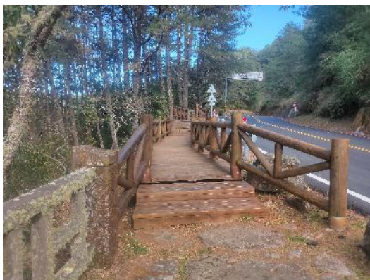
整修台21線公路旁既有木棧道
