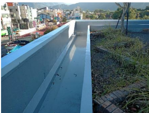
進行露臺防水工程
