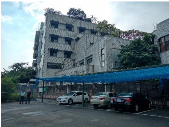
外牆老舊進行防漏工程
