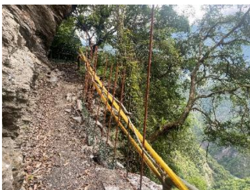
步道 3.1K 路面擴增及過水步道修繕工程
