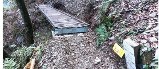
東埔-觀高10.99K(56號)棧橋拆除更新
