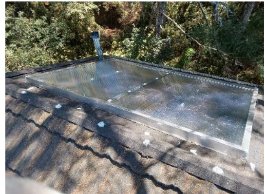
塔塔加-主峰1.7K 孟祿亭生態廁所改善- 屋頂採光中空板
