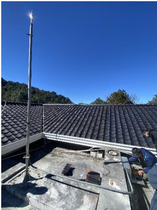
塔塔加管理站辦公廳舍避雷針更新
