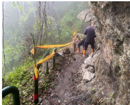
步道 3.1K 路面擴增及過水步道修繕工程
