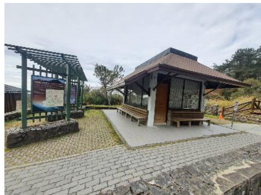
休憩亭新設屋頂斜撐增加安全性
