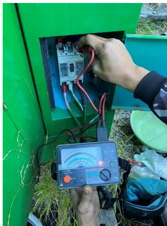
排雲山莊發電機保養案於 11 月 28 日材料送
