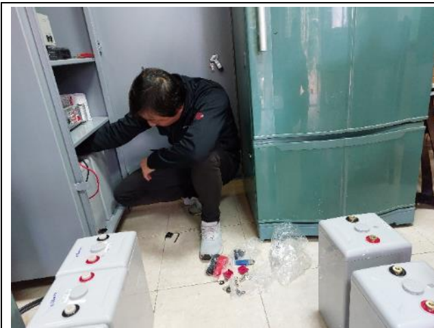
圖 7. 天池無線電中繼臺蓄電系統維護更新
