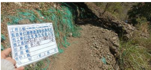
東埔-觀高3.1K 步道上邊坡鬆動土石清理
