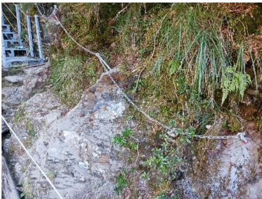
八通關-中央金礦0.5K 路基改善-鑿岩階梯
