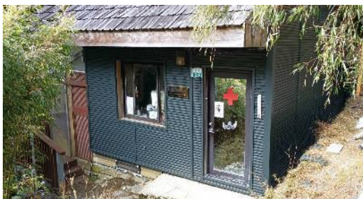
排雲醫療站外牆牆面鋪鍍鋁鋅烤漆鋼板
