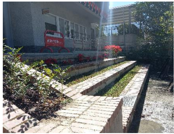
既有階梯花台修繕
