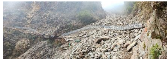
八通關-玉山主峰2.7K 新作鋼筋路基
