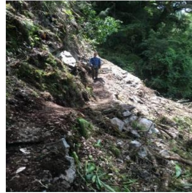
步道巡查路基坍方搶修通行
