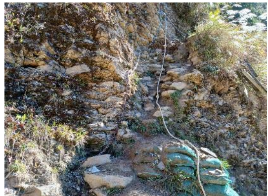
東埔-觀高11.9K 路基改善-鑿岩階梯
