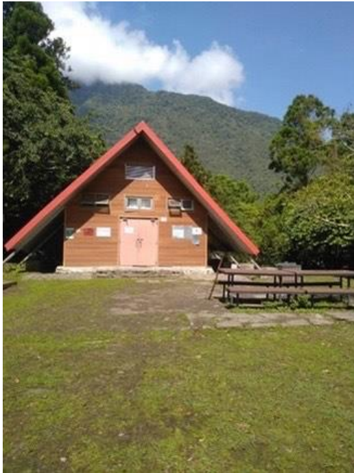
瓦拉米山屋設施整建
