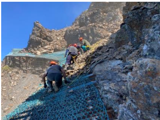
9 月 30 日至 10 月 3 日山莊管理員方有水帶領原住民協同計畫人員前往玉山主峰線風口鐵籠區進行落石清除與刷坡維護工作，避免落石堆積損毀鐵籠設施。
