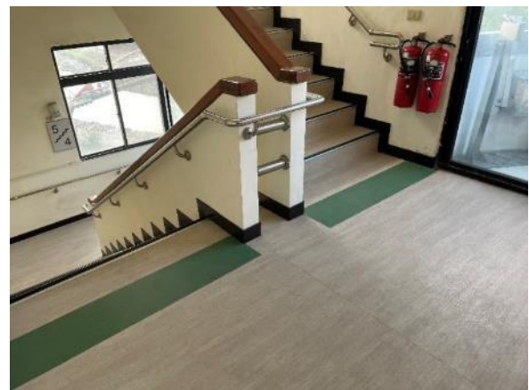
更新老舊建築物內無障礙樓梯踏面
