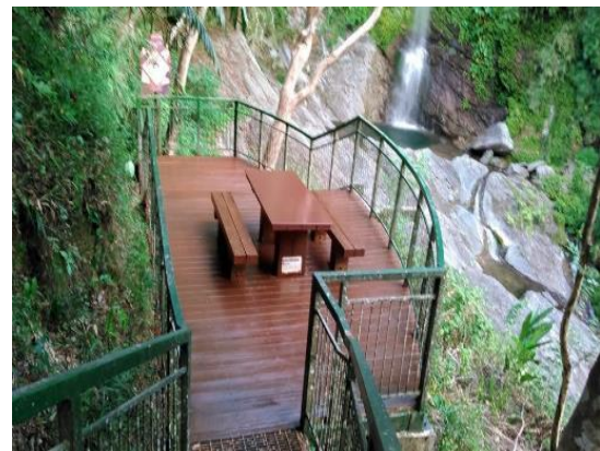
設施維護山風瀑布觀景台護木漆
